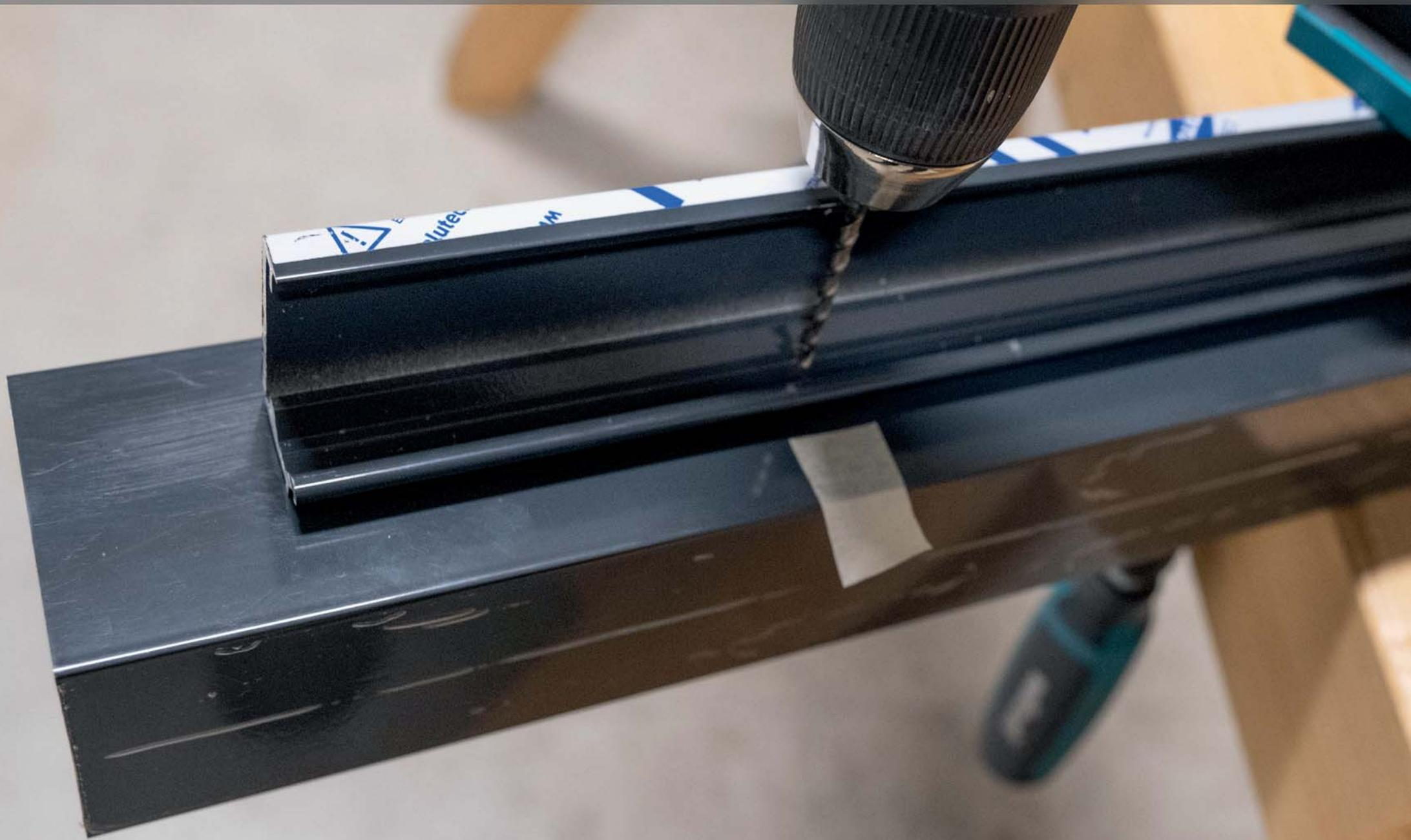
Winkelschiene mit Zaunpfosten verschrauben
