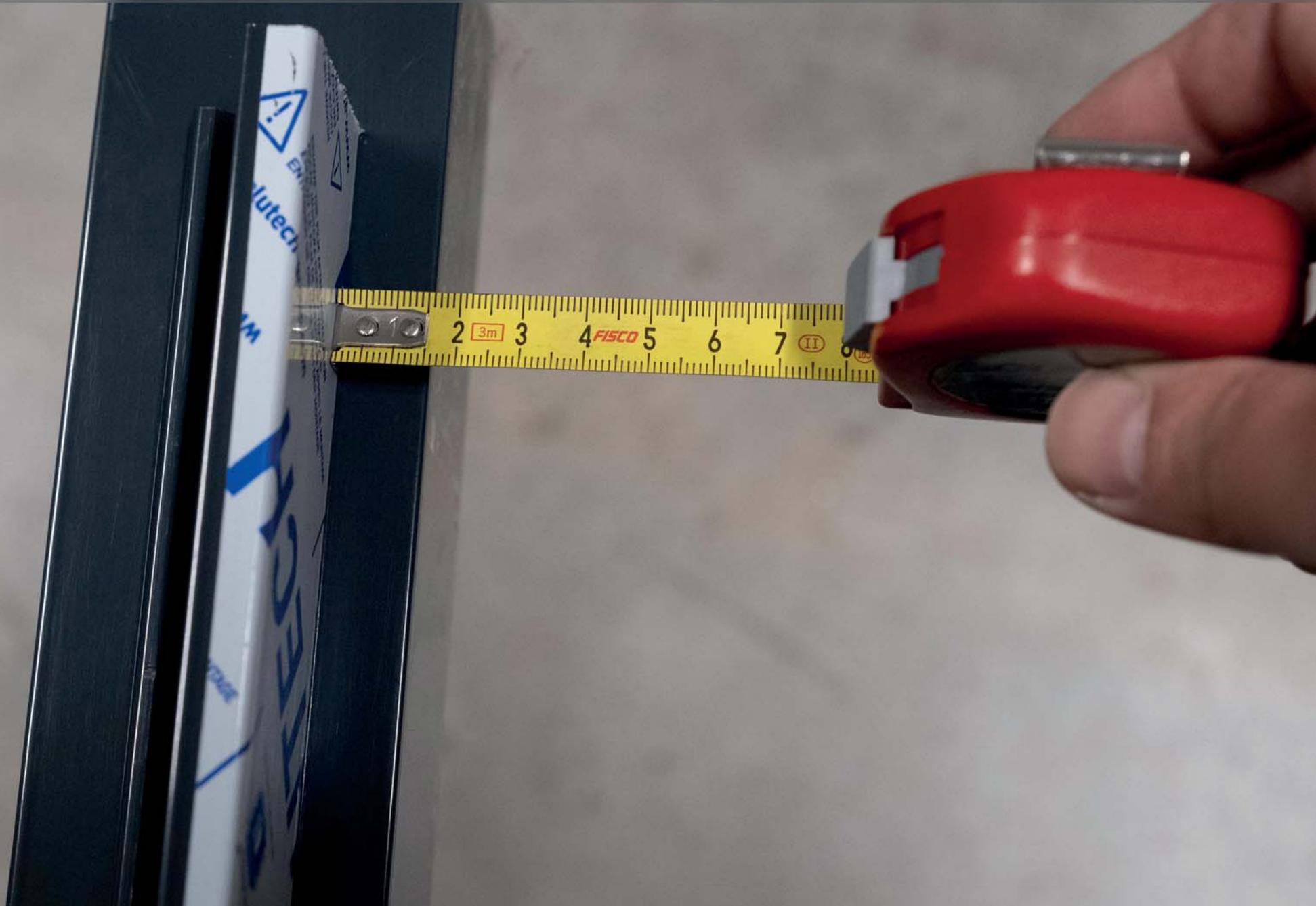
Lochbohrungen: 10 cm von Unterkante-Klemmschiene
